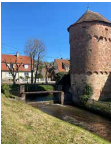
Ecluse de la piscine
