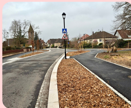
Fin des travaux de la traversée d'Altenstadt, début 2025
