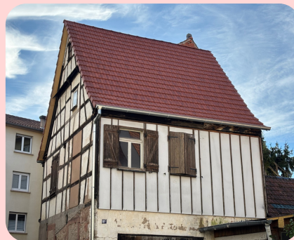
Rénovation rue des Maréchaux, fin année 2025
