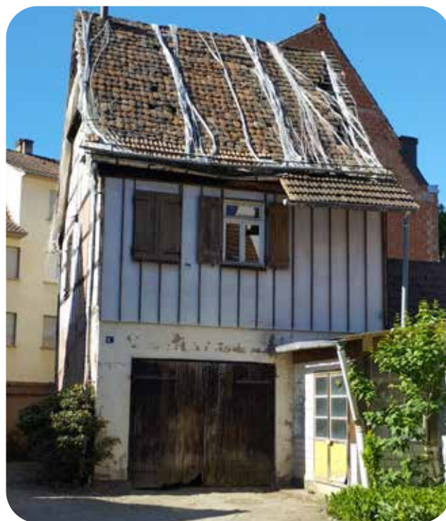
Exemple d'habitation accompagnée par la Ville.
